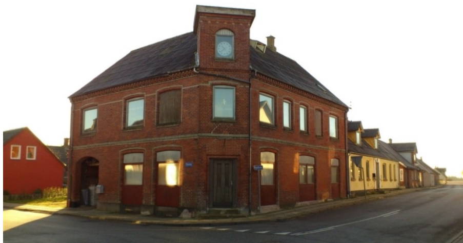
Figur 4.14: Hørдум – Hjørneejendom Tårnvej-Nyhåbsvej. Grund til venstre er blevet ryddet. Det gule hus til højre er modent til nedrivning.
