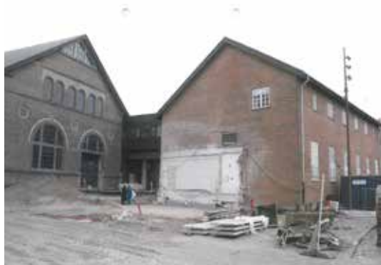
Foto fra Kjellerupsgade efter nedrivning af toiletbygningen
