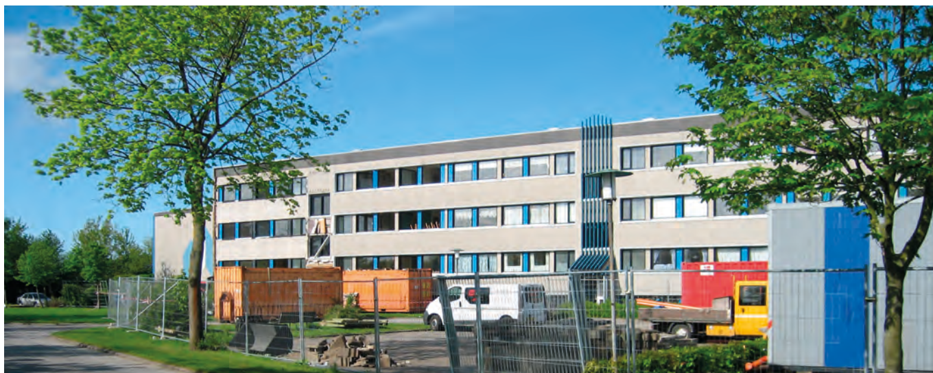
Klimarenovering af blok 1 - opstart.
