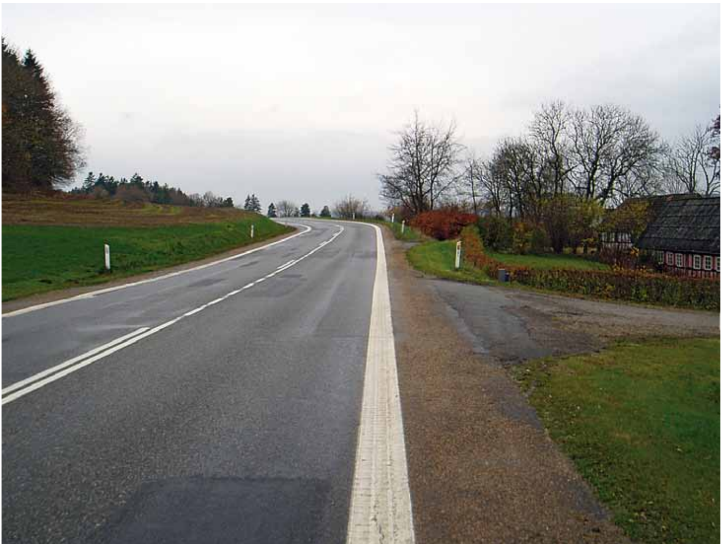
Figur 1. Flere undersøgelser bekræfter, at kurver udgør en væsentlig uheldsfaktor. F.eks. kan dårligt afmærkede kurver som denne være vanskelige at registrere i mørke eller dårligt vejr.
