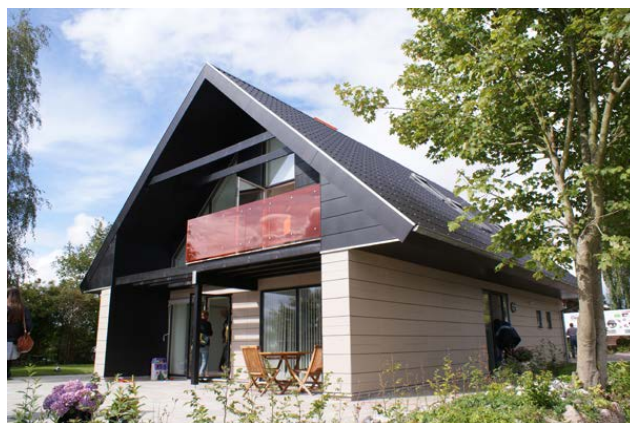
Figur 6: Billede af parcelhus efter renoveringen.
