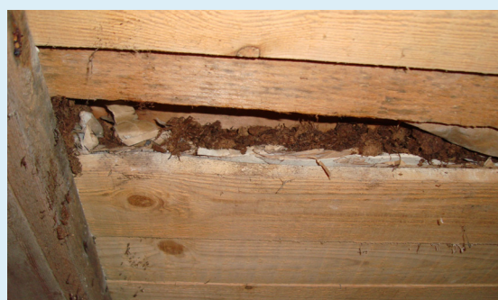
Gulv over krybekælder isoleret med 30 mm tørv.
