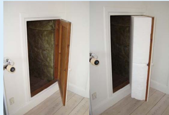
Uisoleret skunklåde til venstre og til højre efterisoleret med 200 mm samt tætnet med en fleksibel klemme langs lågekanten.
