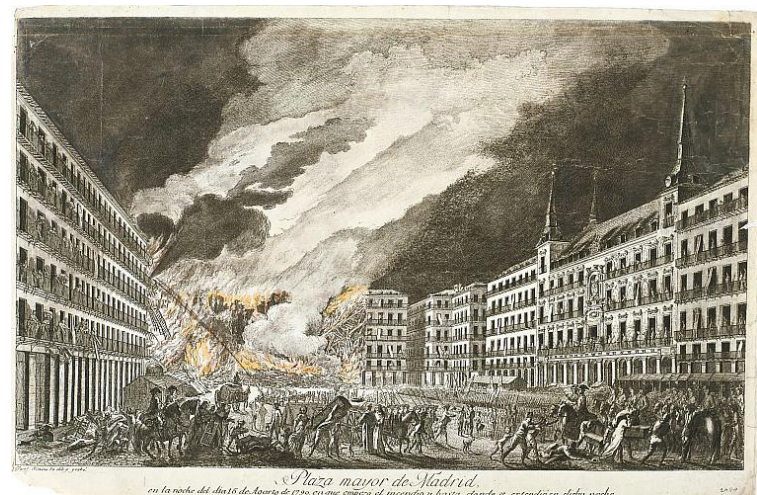
Fig. 16. Incendio de la Plaza Mayor, Madrid , 1790. Autores: José Ximeno.
