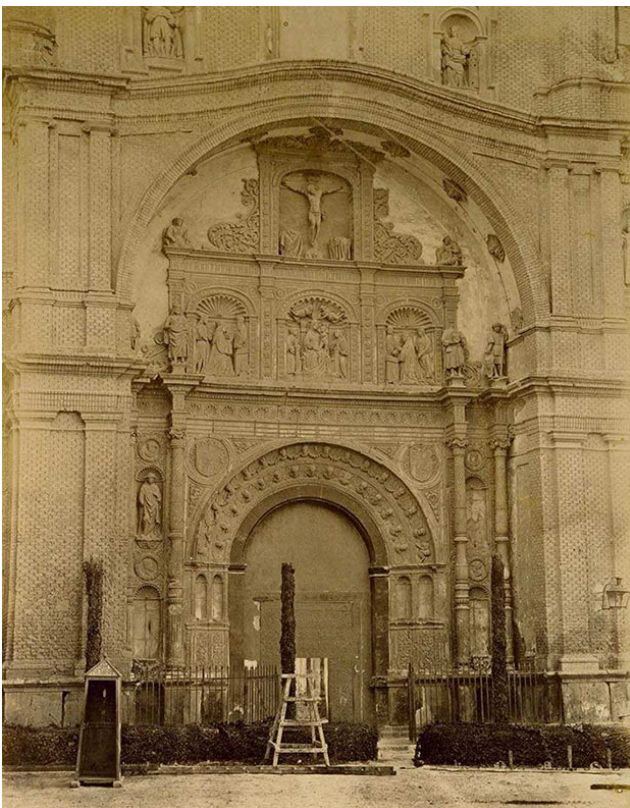
Figura 8. Fachada principal de la iglesia de Santa Engracia (Foto: Charles Clifford, 1860)
