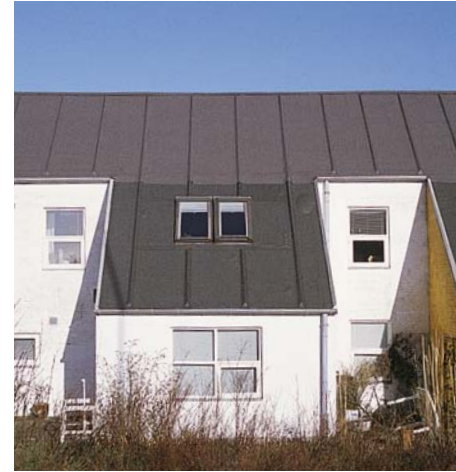
Sol & Vind, Beder, 1981
