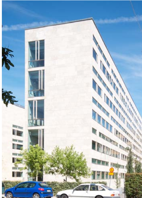
Slank bygningsform Hälsa och Samhälle, Malmö, 2004
