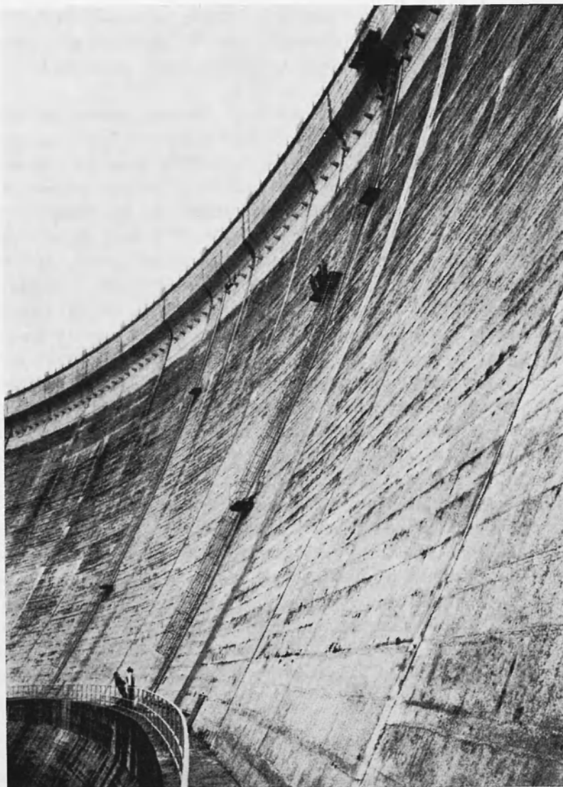
Fig. 3 — Diga di Pieve di Cadore.
