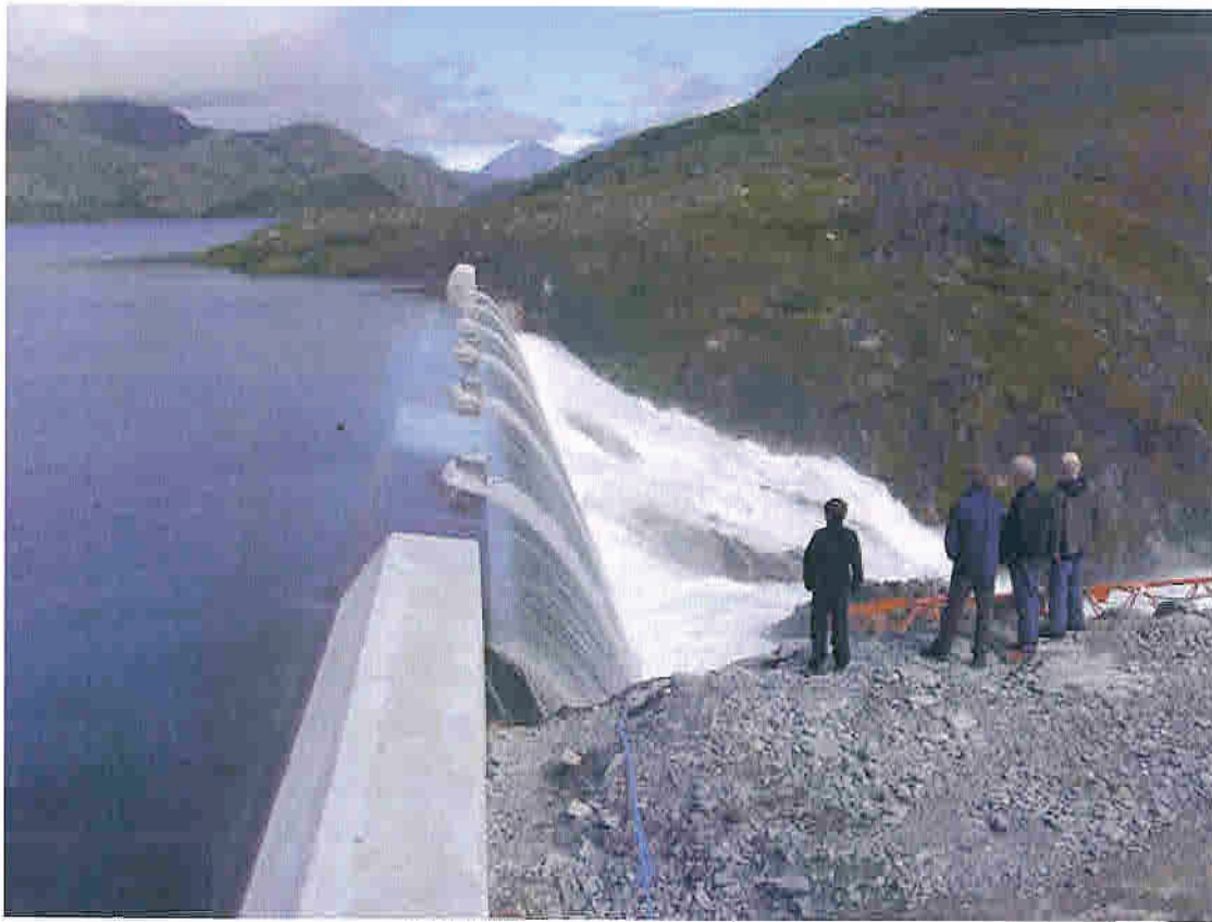
Qorlortorsuaq Vandkraftværk er et af de få store projekter i Grønland, som der er udarbejdet en miljøvurdering for forud for etableringen. (FOTO: RC-Entrepreneurservice)
