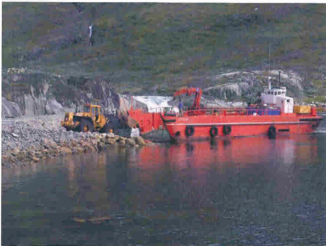
Det er vigtigt at foretage miljøvurderinger i forbindelse med opførelse af miner i Grønland – sådan som det også er sket i forbindelse med Nalunaq Goldmine.
