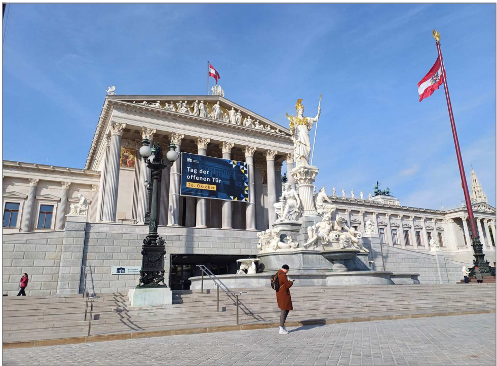
Abb. 11: Parlamentsgebäude am Dr.-Karl-Renner-Ring. Foto: Gemeinsame Baukommission von dbv und VDB
