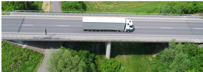
Abbildung 5.1: Brücke in Dietersdorf bei Coburg in Bayern von oben. Aufnahme vom 9. Juli 2021. Der abgebildete Lastkraftwagen (LKW) fährt auf der südlichen Fahrspur in Richtung Osten (Coburg).
