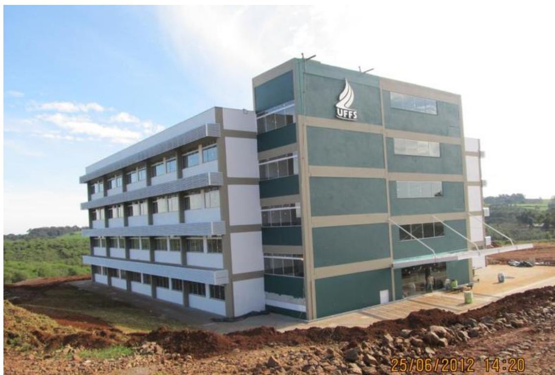
Figura 9 - Bloco A em fase de conclusão
