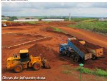
Obras de infraestrutura
