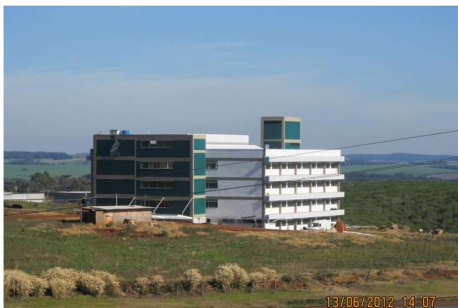
Figura 18 - UFFS Bloco A
