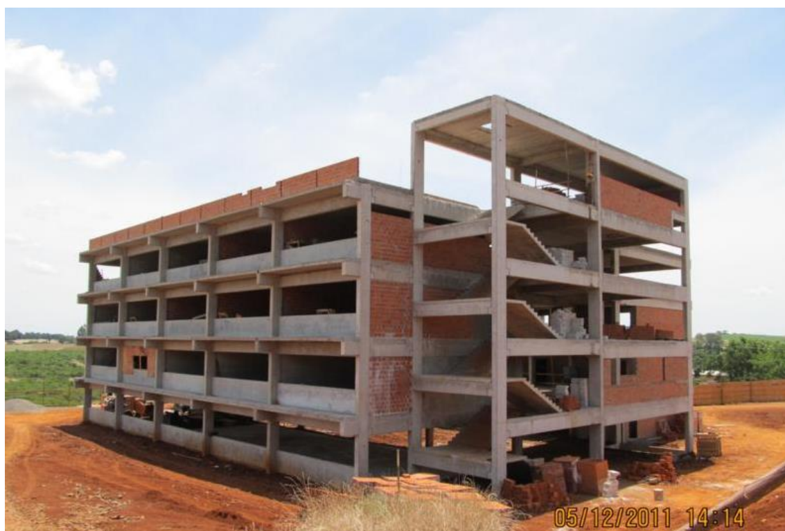
Figura 8- Campus definitivo em fase de construção
