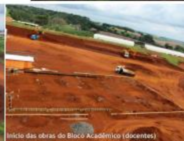
Início das obras do Bloco Acadêmico (docentes)
