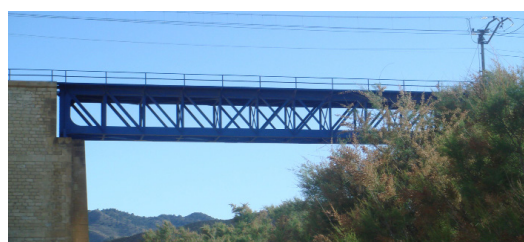
Puente sobre la Rambla de Novelda
