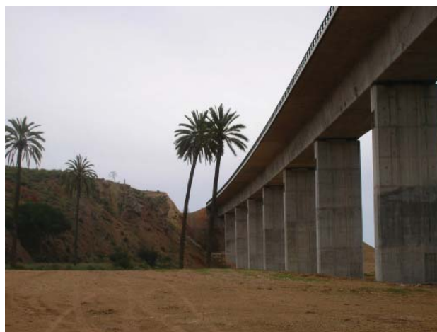
VISTAS DEL TRAMO 4
