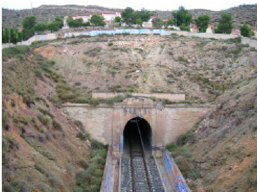
Túnel de Elda, desde ambas desembocaduras de su trazado
