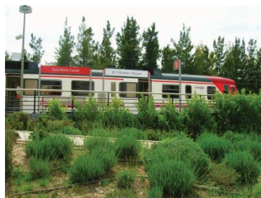
VISTAS DEL TRAMO 9
