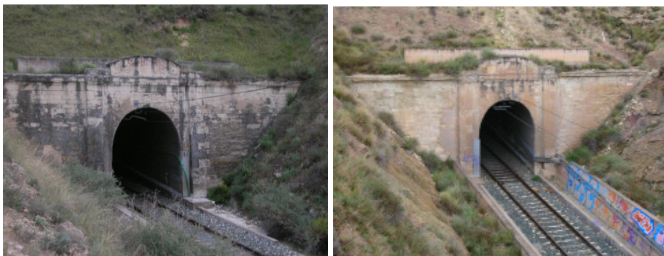
Túnel de Elda, desde ambas desembocaduras de su trazado
