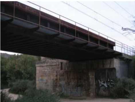
Puente sobre el Río Vinalopó (Elda)
