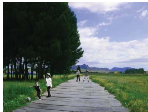
TRAMO DEL RECORRIDO RESUELTO MEDIANTE TRAVIESAS DE MADERA (ENTRE VILLENA Y SAX)
