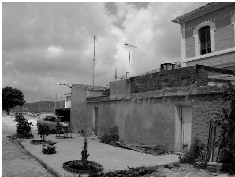
AÑADIDOS DE PROPIEDAD PRIVADA A LA ESTACIÓN DE MONFORTE DEL CID
