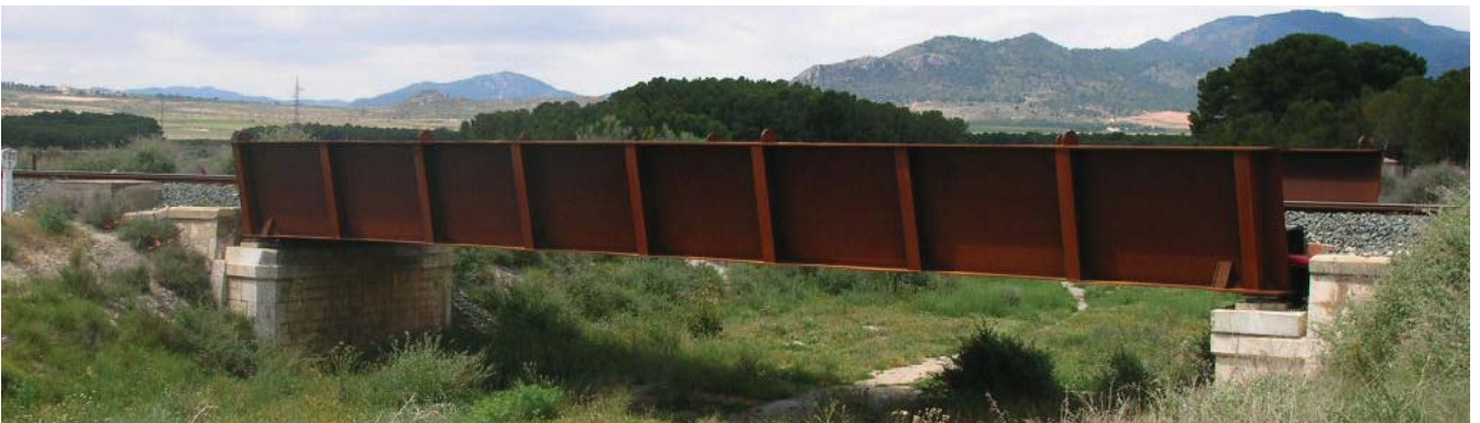
Puente de la Algueña (Villena)
