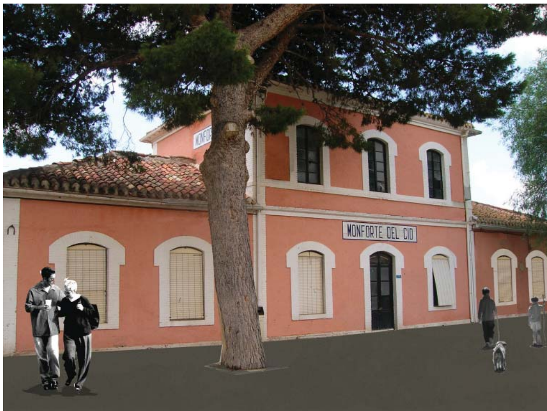
LA ESTACIÓN DE MONFORTE DEL CID ANTES Y DESPUÉS DE SU RESTAURACIÓN. VISTA LATERAL
