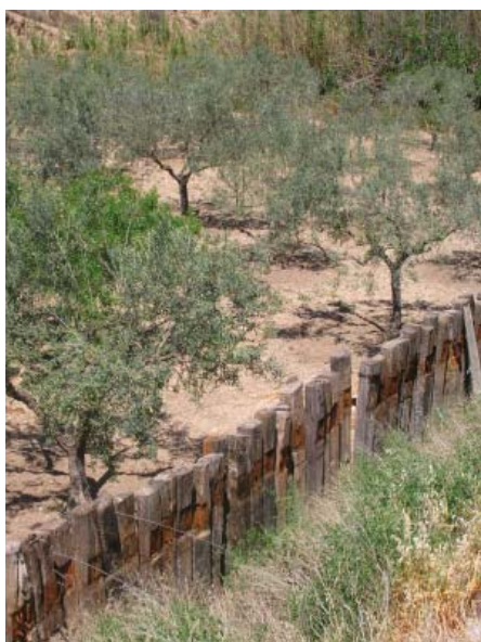
DISEÑO DE MIRADOR SOBRE EL PAISAJE MEDIANTE TRAVIESAS DE MADERA EN SENTIDO VERTICAL, COMO CONSTRUYEN EL VALLADO CON EL MATERIAL DEL LUGAR, EN LA HUERTA DE SAX
