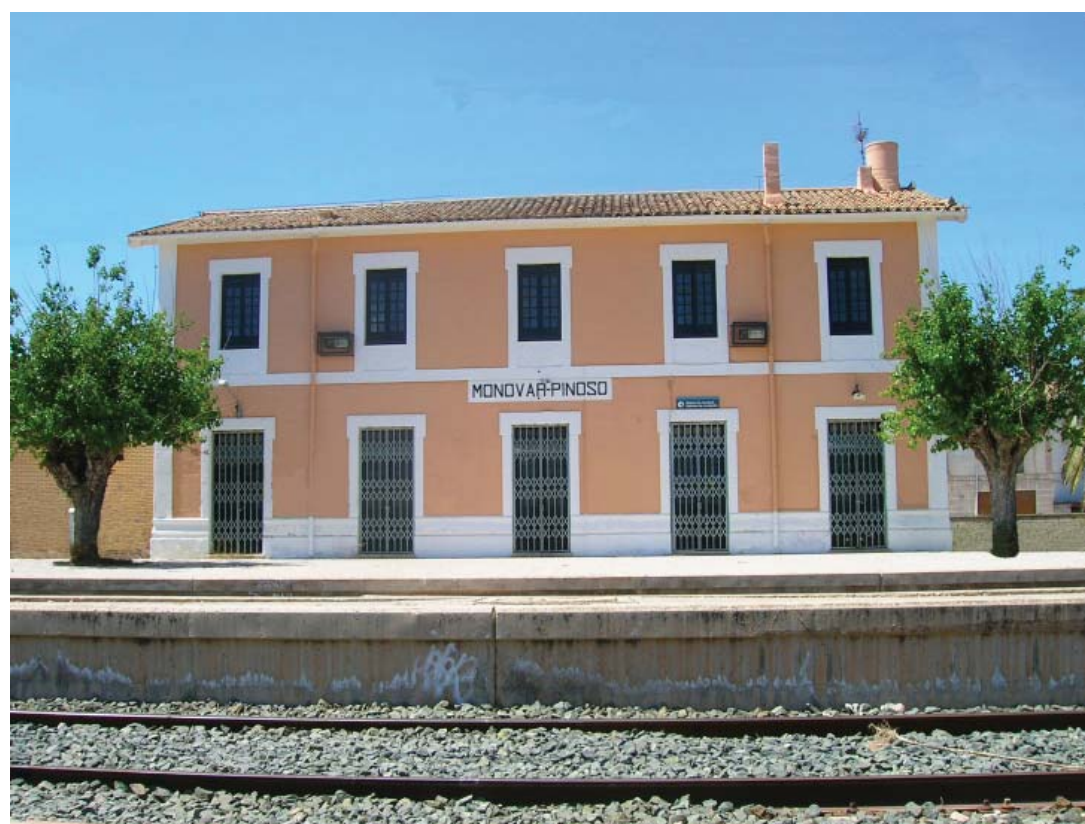
LA ESTACIÓN DE MONÓVAR-PINOSO ANTES Y DESPUÉS DE SU RESTAURACIÓN. VISTA FRONTAL
