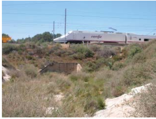
Puente de las Salinetas (Monóvar)
