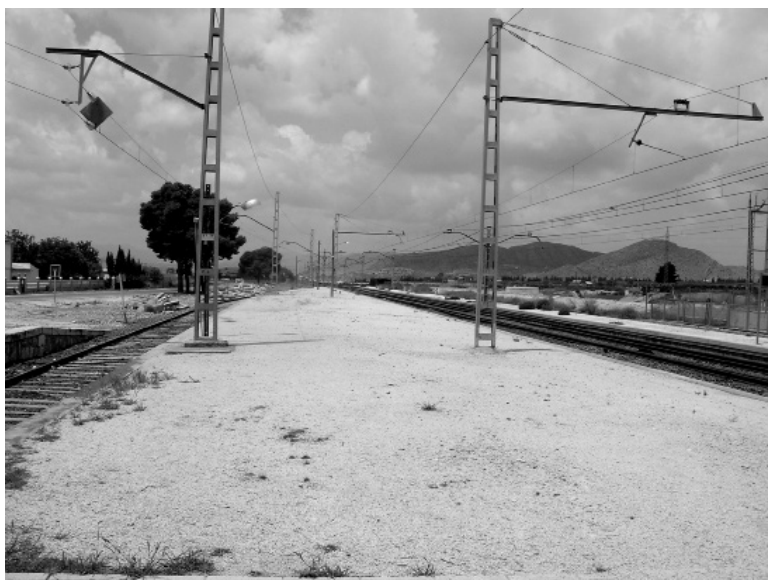
ASPECTO DE LAS INMEDIACIONES Y ANDENES DE LA ESTACIÓN DE MONFORTE DEL CID
