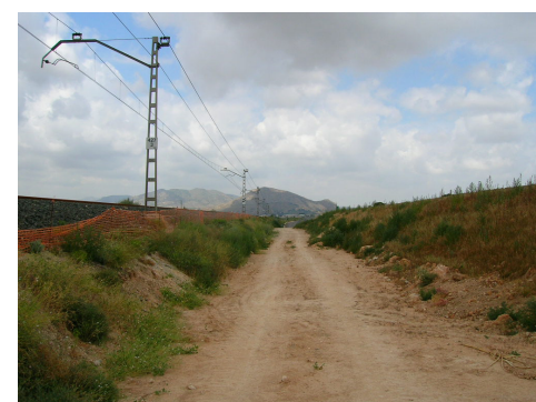
VISTAS DEL TRAMO 7
