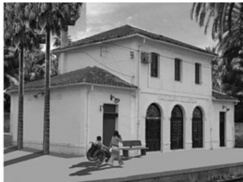
Figura 18: Estación de San Vicent del Raspeig y posible transformación (rehabilitación). Fuente: María Mestre Martí.
