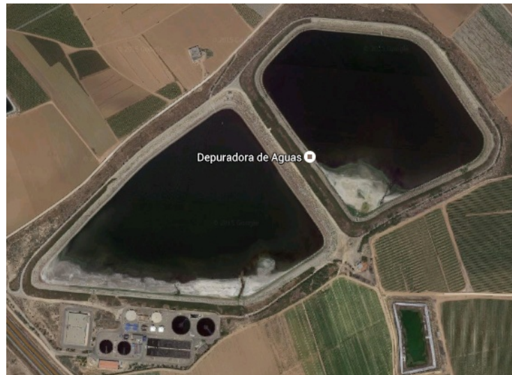
Figura 3.3: Vista aérea de la EDAR (Fuente: Google maps).
