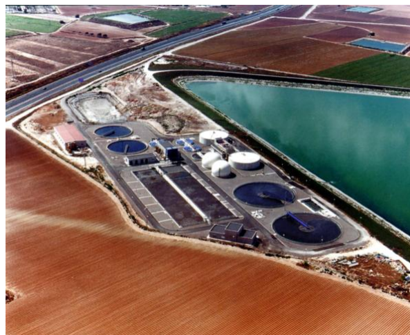
Figura 3.4: Vista aérea de la EDAR (Fuente:
