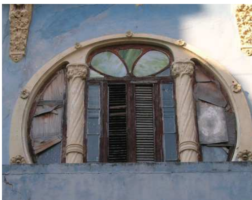
Izq. Vivienda en las calles Concordia y Aramburu. La Habana.
