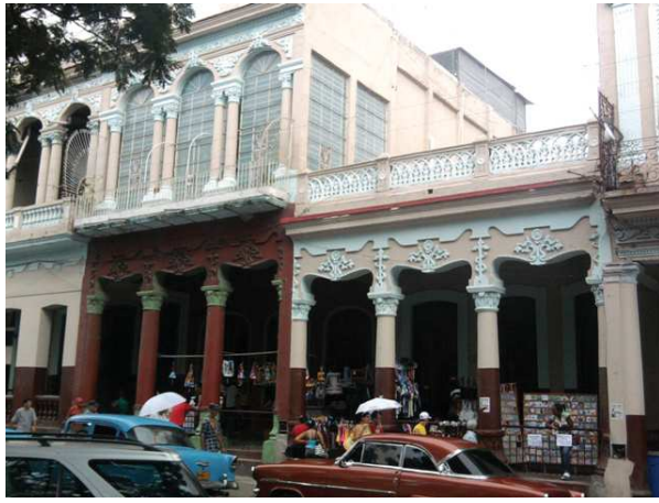
FIG. 83. Viviendas en la Avenida Carlos III de La Habana.
