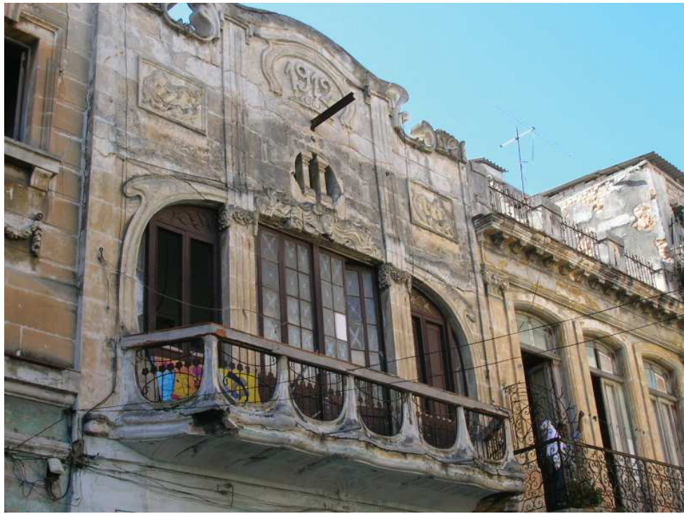
FIG. 82. Edificio en la calle Neptuno #657 entre Gervasio y Belascoín, La Habana.
