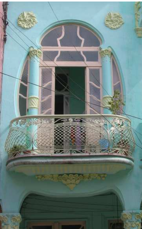
Vivienda en la calle Cárdenas #107. La Habana.
