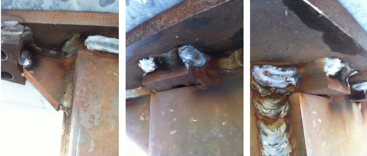
**Ilustración 67. Detalle de soldaduras Grand Soleil 37**
