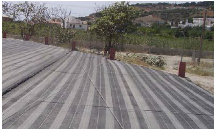
Foto 3: Cobertura de sombrero suspendida (Maestre-Valero, 2011).
