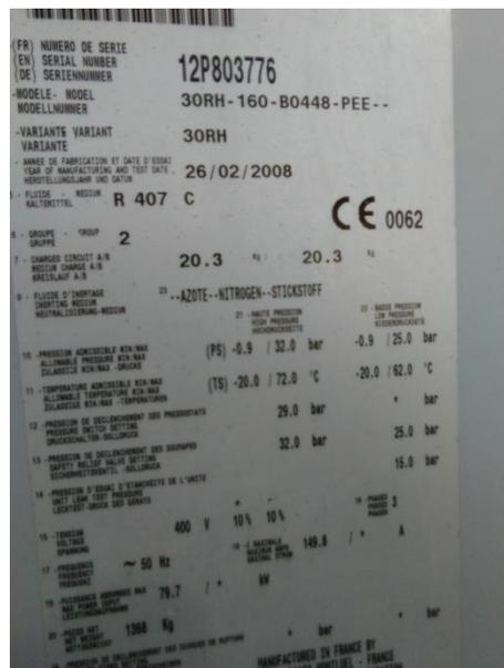
Ilustración 31: Placa características planta enfriadora
