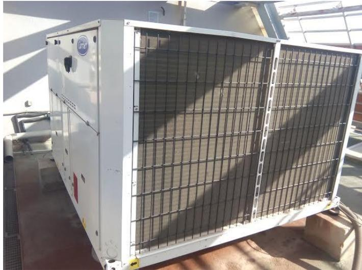
Ilustración 30: Planta enfriadora en la cubierta del edificio
