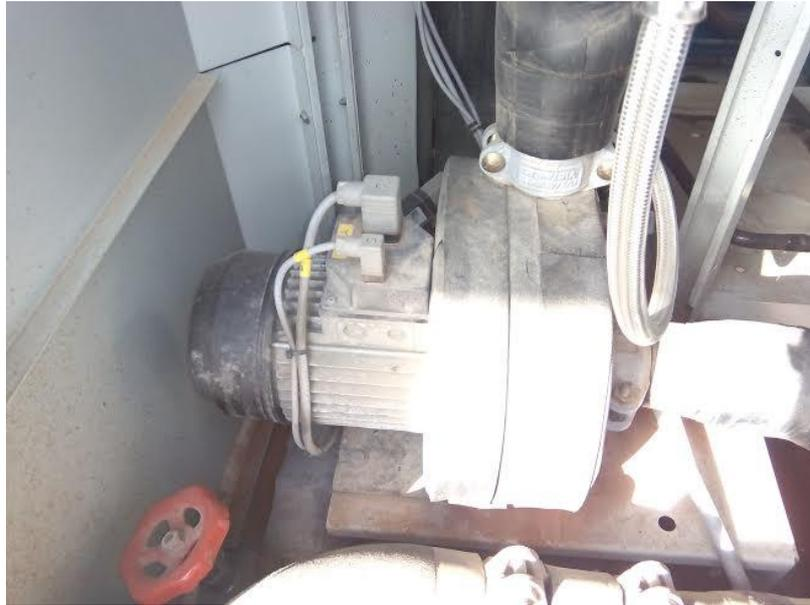
Ilustración 40: Bomba módulo hidrónico
