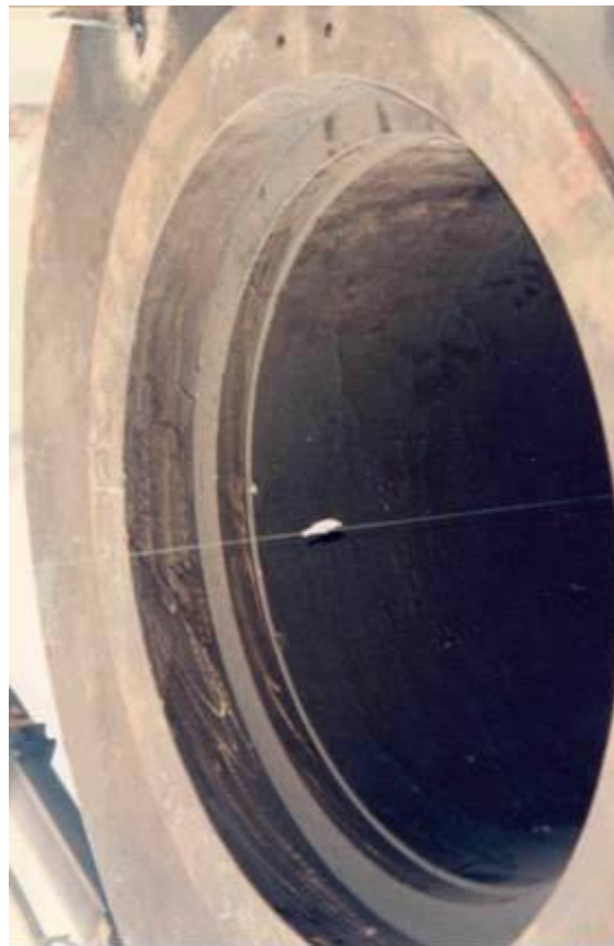
Figura III. 18 - Aplicación del "cable de acero"
