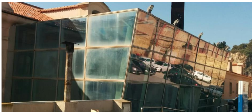
Imagen 112: Espacios con cerramientos de cristaleras.
