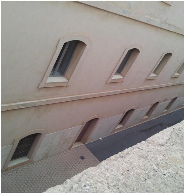
Imagen 130: Distancia entre cerramiento exterior y el terreno.
