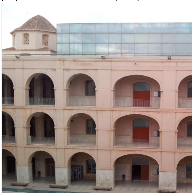
Imagen 128: Cúpula sobre escaleras.
