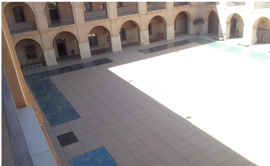
Imagen 93: Lucernarios sobre aulas de sótano.
