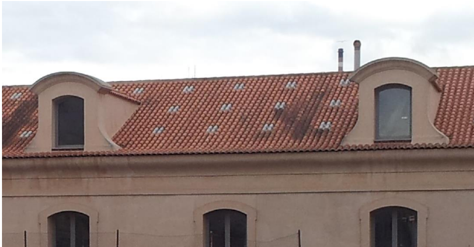
Imagen 90: Cubierta del edificio de Hospital de Marina.
