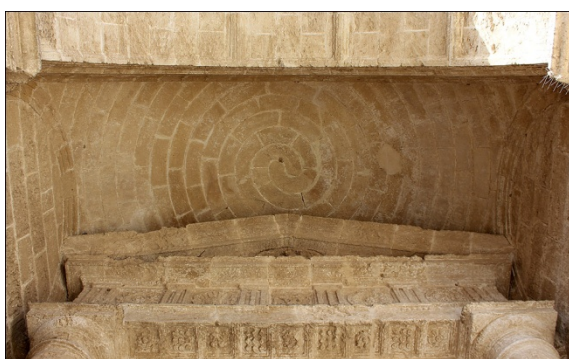
Fig. 1. Bóveda baída en el vestíbulo de acceso.
