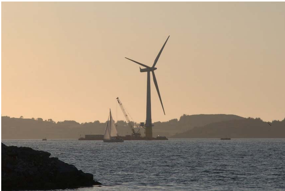
Figura 1.5: Proceso de montaje del proyecto Hywind frente a las costas de Stavanger (Noruega) antes de su emplazamiento definitivo en el Mar del Norte. Fuente: www.wikipedia.org .
