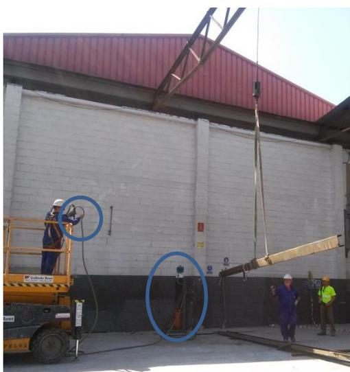
**Foto 14:** desmontaje de cubierta metálica para instalación de depósitos
