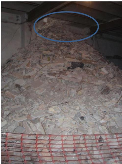
**Foto 8:** Foto de acumulación de escombros en planta baja del edificio.
