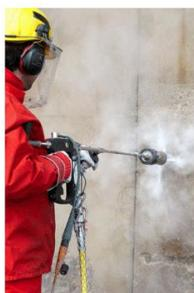
(Fuente: Equipos de hidrodemolición Hammelmann)
