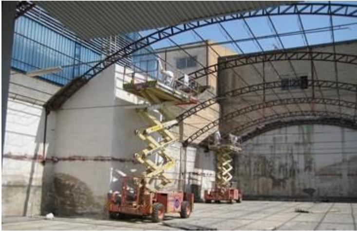
**Foto 22:** Desmontaje previo de cubierta de fibrocemento (comercialmente conocida como uralita)
