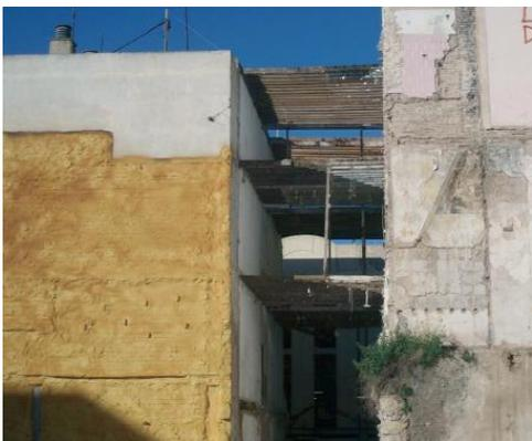
**Imagen 1:** Vigas que forman parte de edificios colindantes. Ejemplo de elementos que no se pueden demoler (AECOM, 2012: 41)
