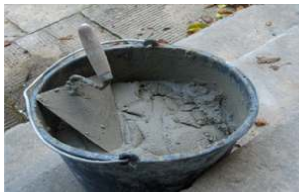
Figura 2. Mezcla de Concreto
