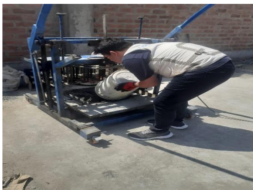
Vaciado a la maquina
