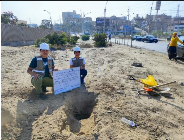
Imagen 33: Excavación de la calicata N° 1
