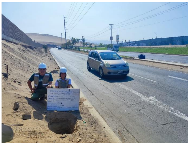
Imagen 35: Excavación de la calicata N° 3
