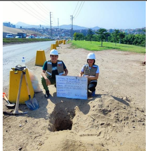
Imagen 34: Excavación de la calicata N° 2
