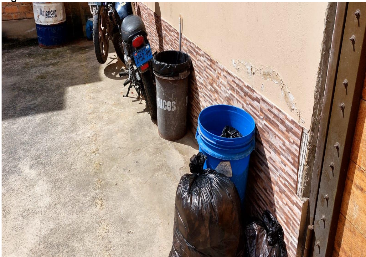
Figura N° 14. Tachos de residuos no son los adecuados.
