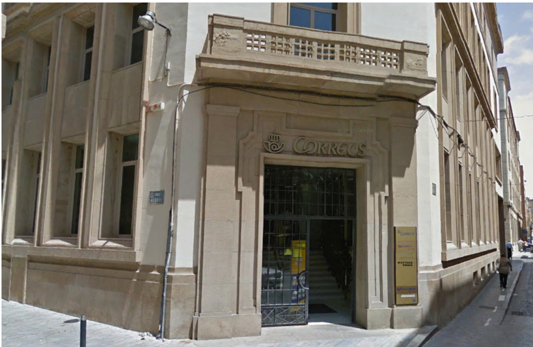
Fig. 43 Entrada Edificio de Correos
