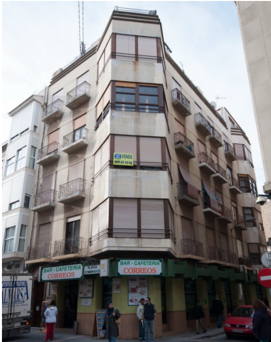
Fig. 35 Edificio Calle de la Caridad, 11
