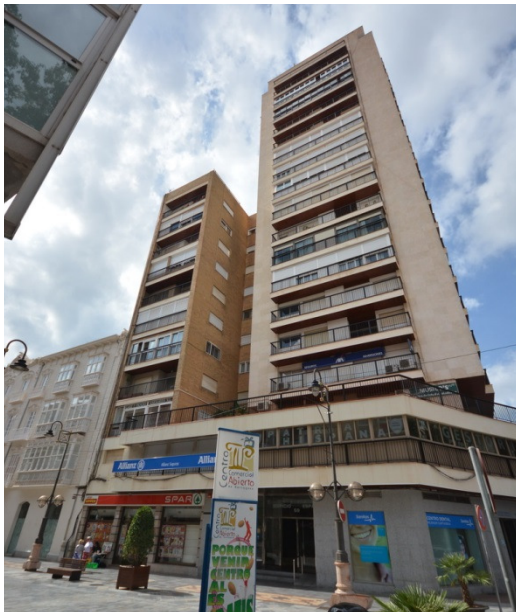
Fig. 16 Edificio Calle Real, 38
