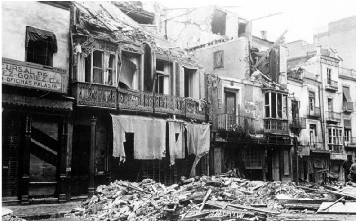
Fig. 11 Daños provocados por el "bombardeo de las cuatro horas" en Cartagena
