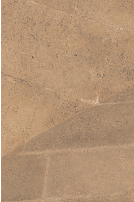
FIGURA 12. DOVELAS INTERMEDIAS QUE FORMAN PARTE DE UNA PECHINA Y DE UN MURO.
