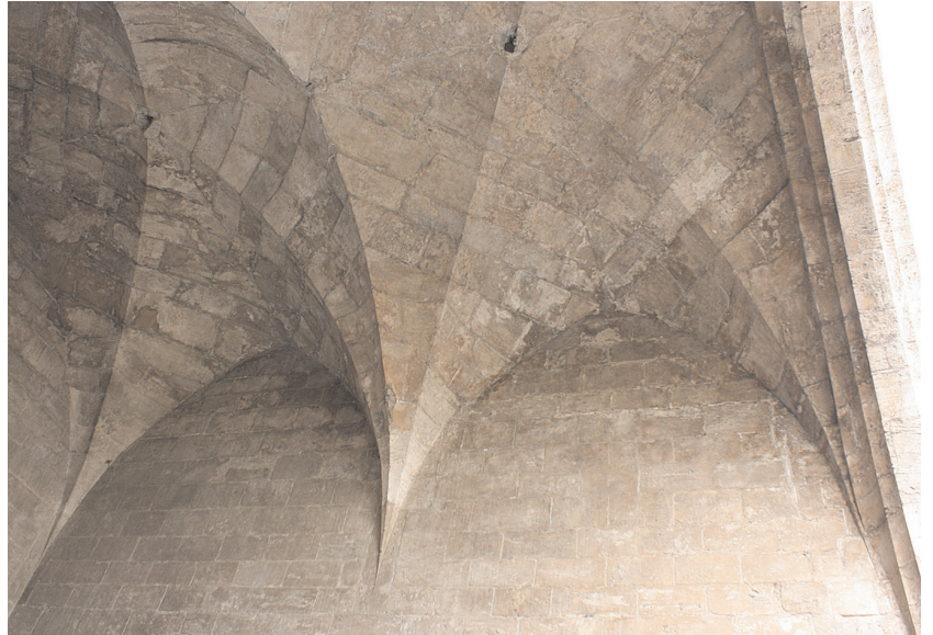
FIGURA 17. BÓVEDA DE CRUCERÍA ANERVADA EN LA TRIBUNA CENTRAL DEL PORTAL DE QUART (1441-1460), OBRA DE FRANCESC BALDOMAR
