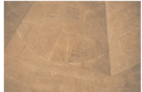
FIGURA 9. ARRANQUE DE LOS GALLONES DESDE EL ANILLO CILÍNDRICO.
