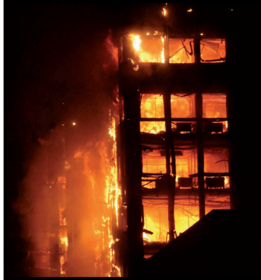
Fig. 5.8 La fachada por encima de la planta técnica del piso 16 quedó completamente destruida
