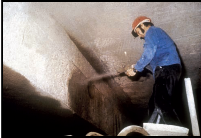
Fig. 5.4 Reparación de elementos con gunita (hormigón proyectado)
