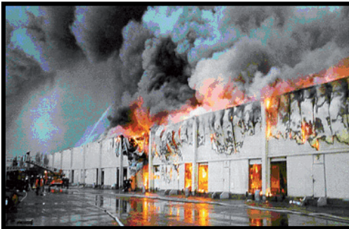
Fig. 5.13 Los paneles sándwich ligeros se derrumbaron en este incendio propagándose a los edificios adyacentes
