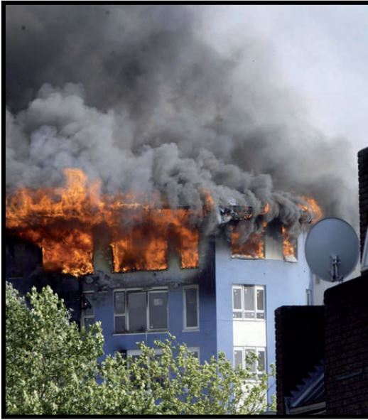
Fig. 5.12 El incendio de Colindale de los edificios residenciales con estructura de madera en construcción duró 5 horas y precisó de 100 bomberos y 20 bombas para controlarlo.
