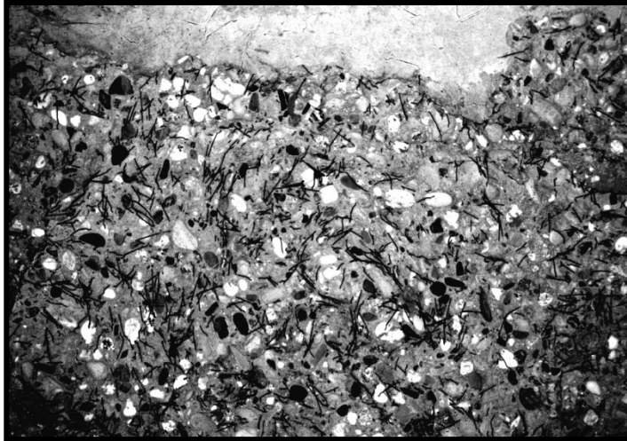
Fig. 8.7 Losa de hormigón con cóctel de fibras después del ensayo frente al fuego
