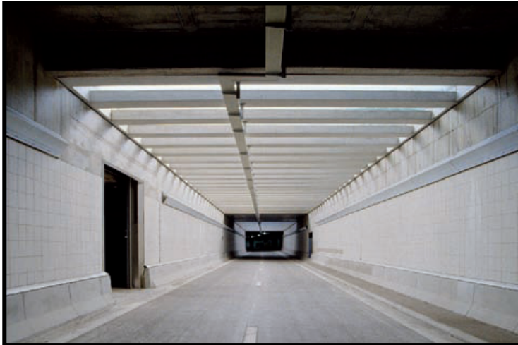
Fig. 5.10 Los pavimentos de hormigón pueden resistir las temperaturas muy elevadas que se producen en los incendios de los túneles
