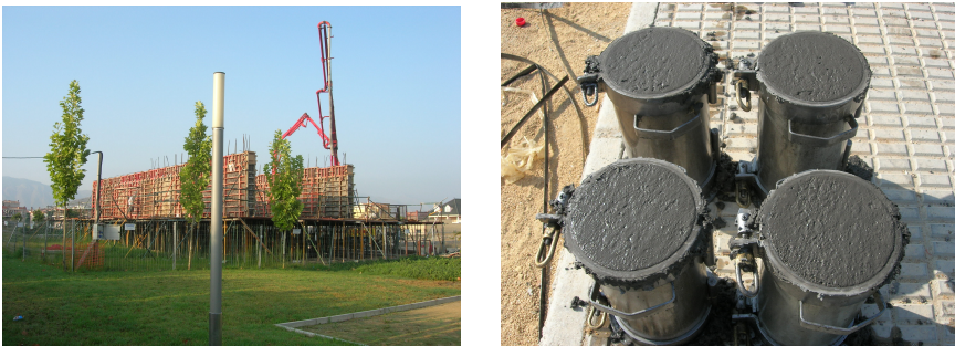
(a) Vista general de la obra (b) Probetas ejecutadas en obra.
