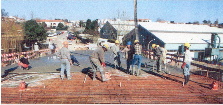
Figura 2.1 – Aspecto general de un hormigonado con hormigón convencional
