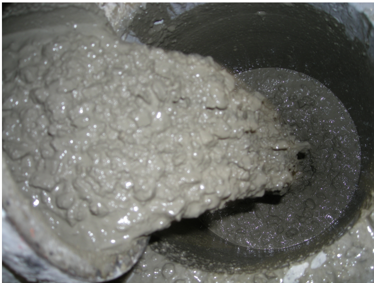
Figura 2.7 – Hormigonado bajo la losa de cimentación con HAC
