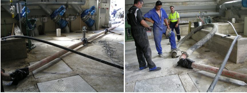
(a) Tubería para el vertido de HAC desde punto exterior (b) Hormigonado mediante bombeo con gran longitud de tubería.
