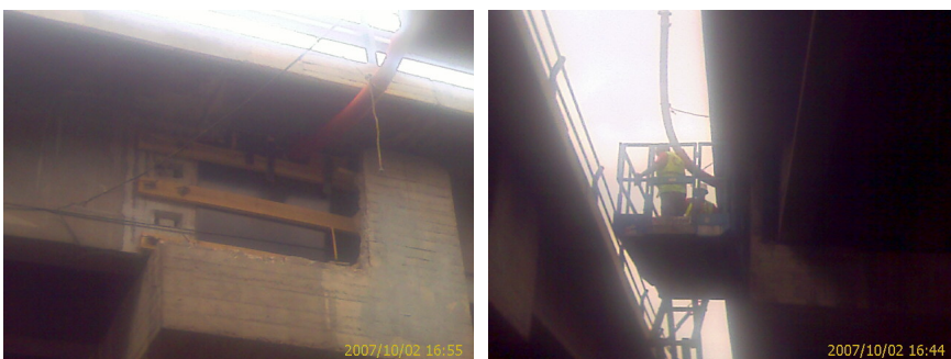
(a) Preparación del punto de Hormigonado (b) Hormigonado del cajón de hormigón del viaducto
