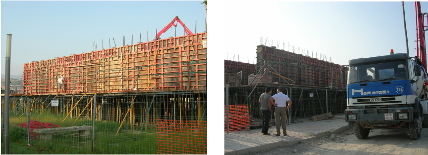
Figura 2.11 – Hormigonado de la pieza
