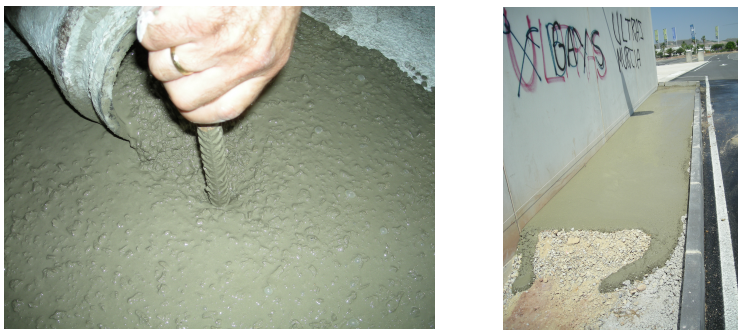
(a) Comprobación de llenado último agujero (b) Avance del HAC
