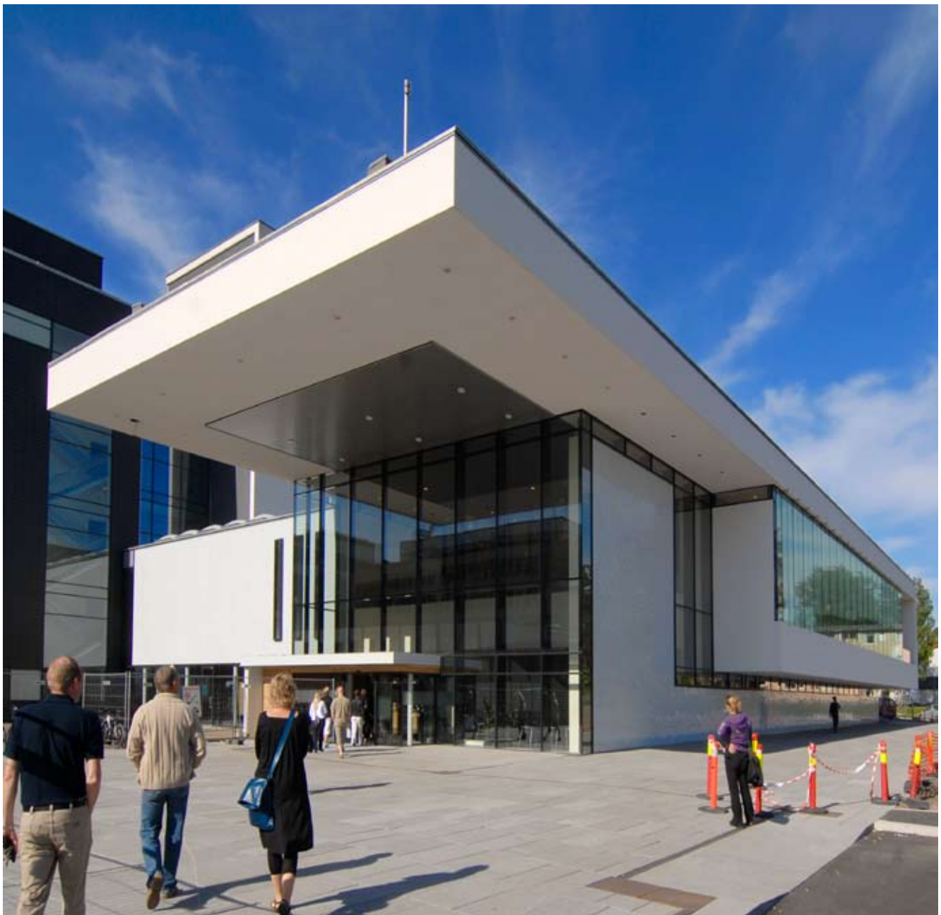
Markeret hovedindgang, A-Hus, Oslo
