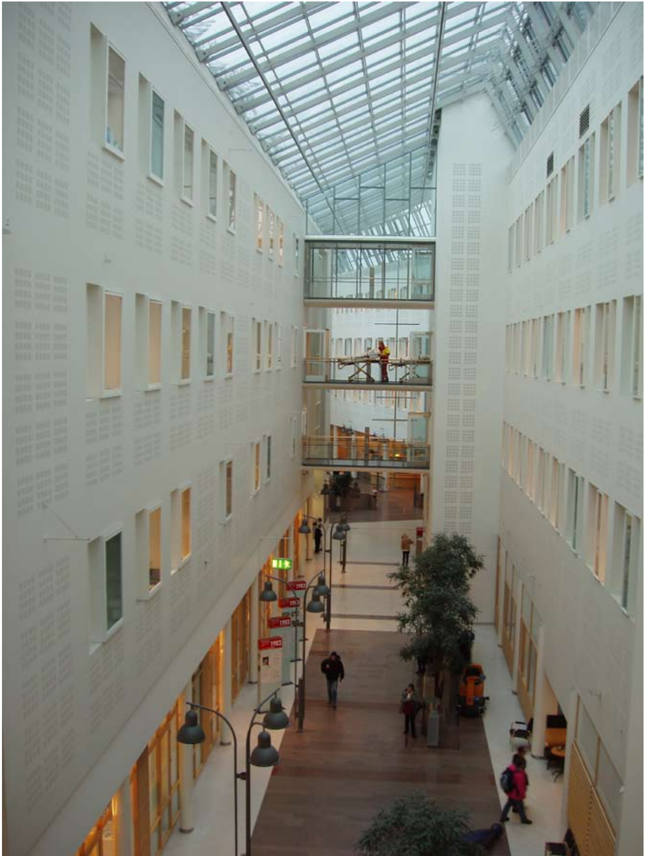
Akustisk regulering integreret i facadebeklædningen, Rikshospitalet Oslo
