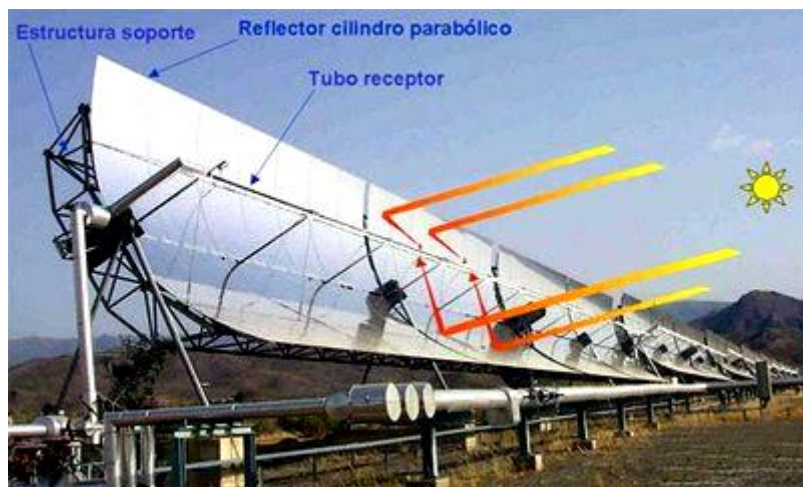
Figura 4. 44: Componentes de un captador solar cilíndrico-parabólico
