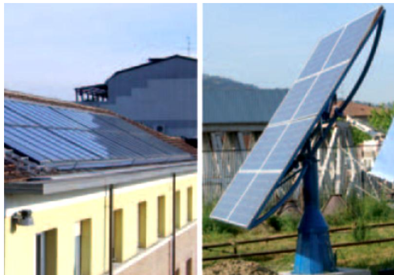
Figura 4. 72: Paneles solares de posición fija (izquierda) y con sistema de seguimiento (derecha)
