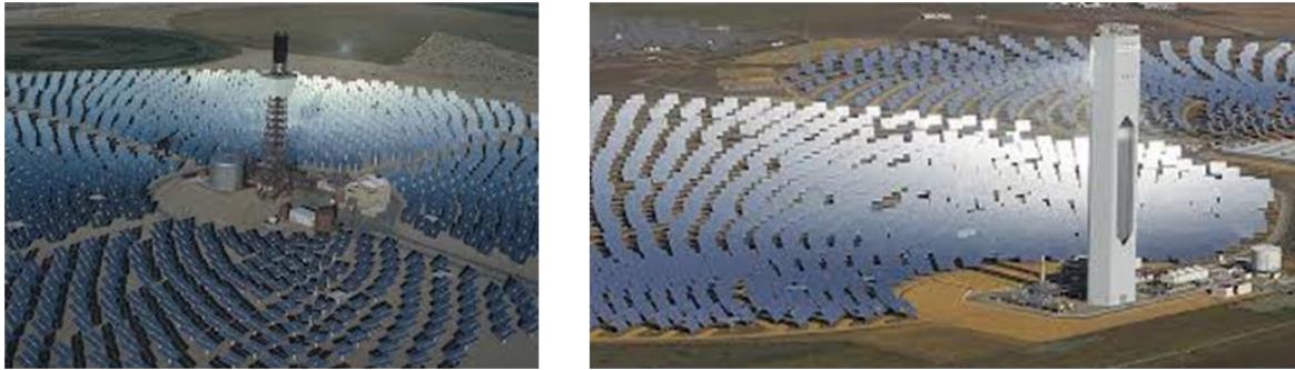
Figura 4. 46: Centrales de torre. Izquierda: Campo circular. Derecha: Campo norte
