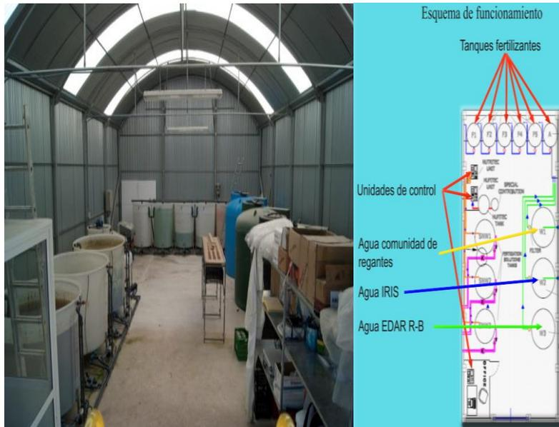
**Foto 4.** Cabezal de riego. Detalle del sistema CLINVERTEC® y del esquema interior del cabezal.
