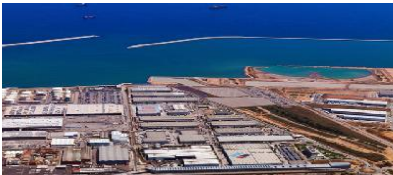
Figura 6.3.2. C. Plataforma logística Barcelona ZAL
