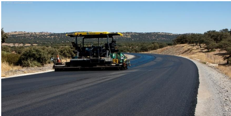
Figura 9.6.3.1. Carretera de mezcla bituminosa con polvo de caucho
