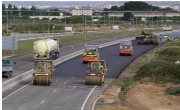
Figura 2.6.3.A. El proyecto Fénix desarrollará nuevas mezclas asfálticas
