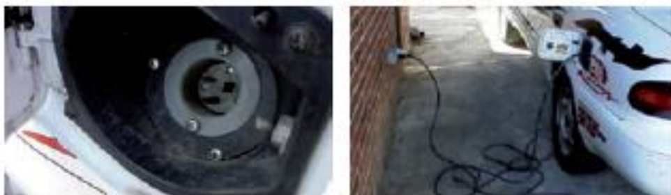
Figura 11.3.2.B Recarga de las baterías de un vehículo eléctrico
