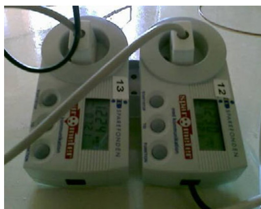
Figur 50: Logning af energi-forbrug med energimålerne (Spar-O-Metre) udlånt af Elsparefonden.
