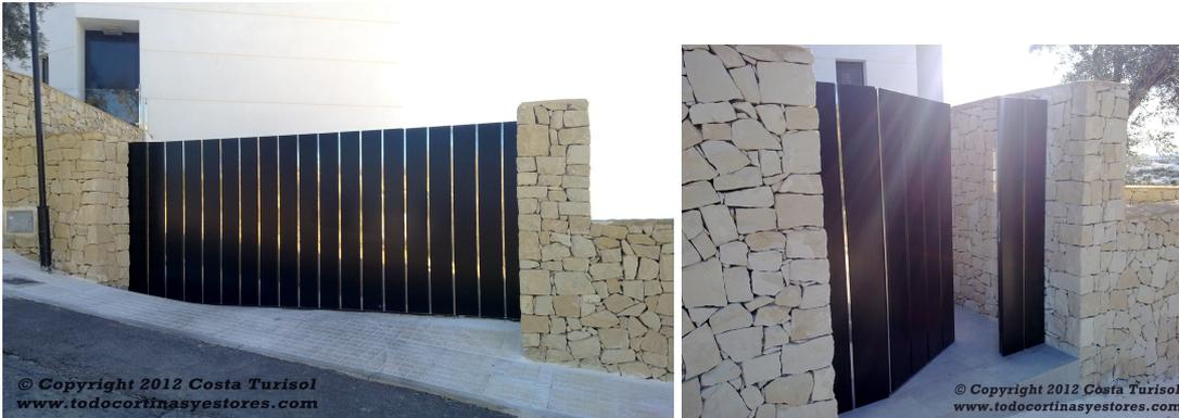
Puertas exteriores para el muro perimetral de la vivienda del suministrador Inox-ferro de acero inoxidable de color negro. La puerta de entrada para personas es abre hacia el interior y la puerta de entrada para coches es sobre rieles abriéndose mecánicamente.
