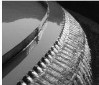
Figura 18. Salida de agua decantada.
