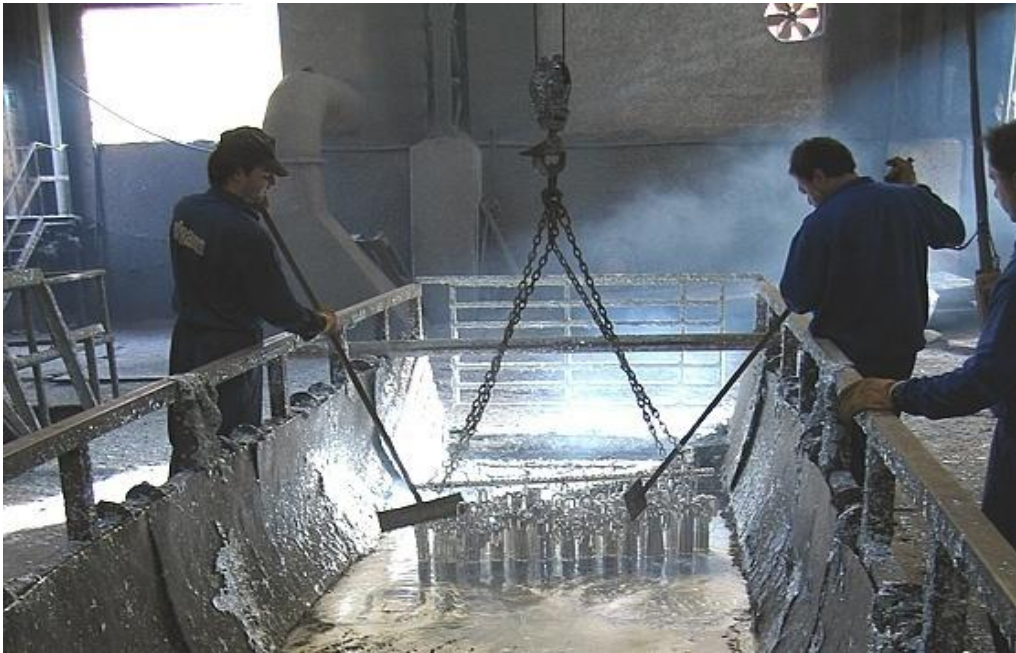
Figura 3.2. Operarios realizando el baño de Zinc
