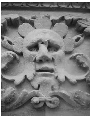
Figura 5. Cata de limpieza en seco realizada en la actuación 2004. Foto UTE Azuche-Villegas.
