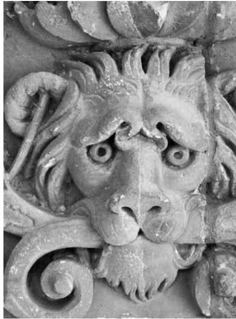
Figura 8. Prueba de limpieza con láser en la cara del león de la zona labrada del entablamento de la fachada Este. F. Artelan.
