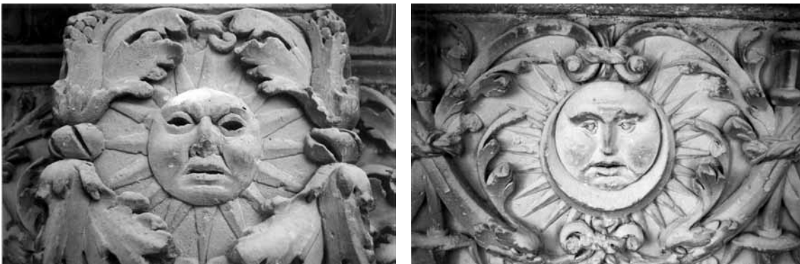
Figuras 3 y 4. Relieves de friso de la fachada Norte. Antes de la intervención de 2004. (Fotos JC M G)
