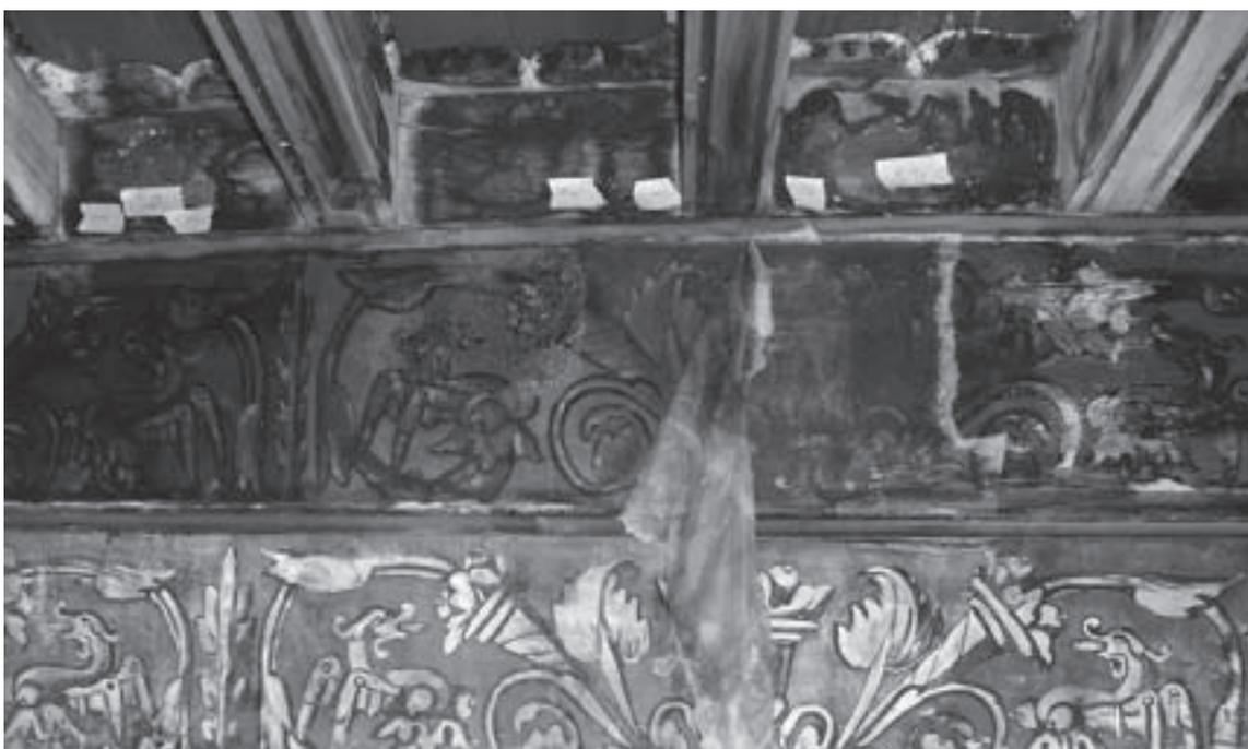
a base de coleta italiana y sulfato cálcico dihidratado hasta la saturación del mismo. Posteriormente se igualaron las superficies hasta enrasarlas con el original.
