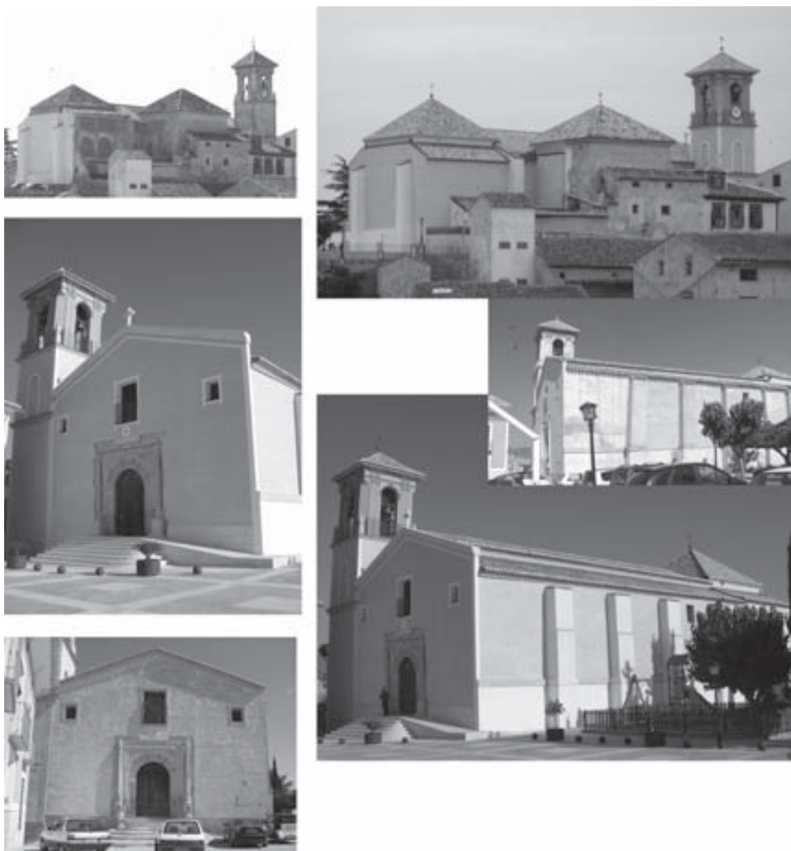
Distintas imágenes de las fachadas del Templo en su estado previo y final, una vez aplicados los morteros de cal, ejecutados los aleros de plomo, así como el resto de las cubiertas.
