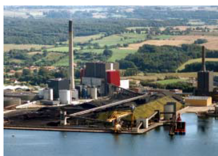
Enstedværket (Dong Energy, 2007a)
