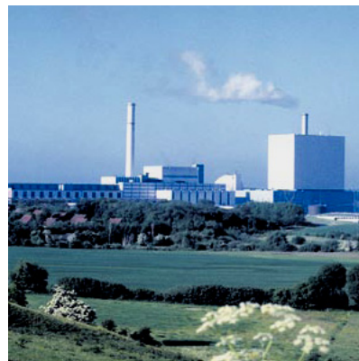
Skærbækværket (Dong Energy, 2007b)
