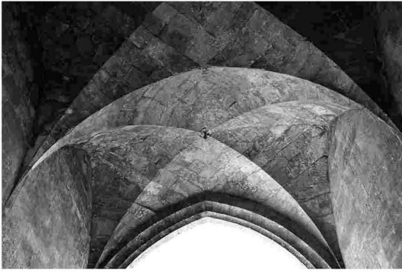
Figura 2. Bóveda de arista esviada en la tribuna central de las Torres de Cuarte. Como puede apreciarse, está ejecutada únicamente con piezas enterizas.
