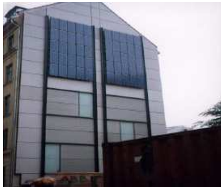
Foto: Colocación sobre estructura auxiliar en fachada.
