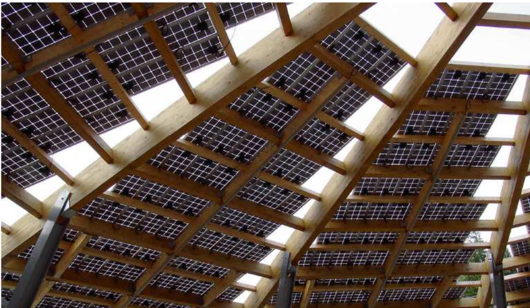
Lucernario en el edificio del Centro de Estudios Medioambientales As Pontes (La Coruña)
