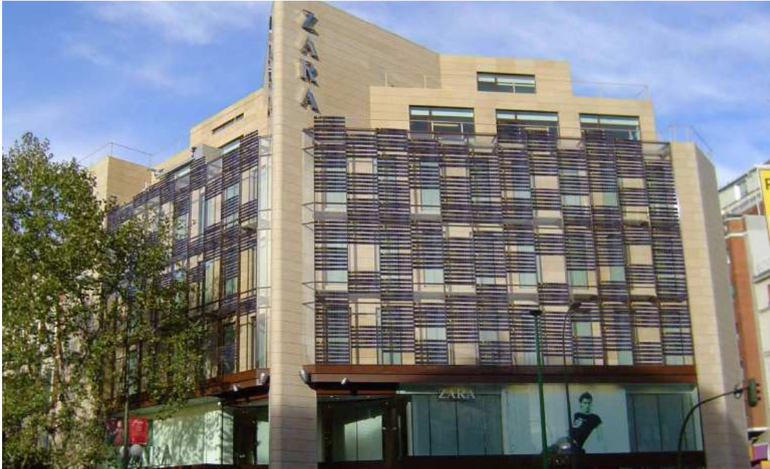
Fachada fotovoltaica Zara (Madrid)
