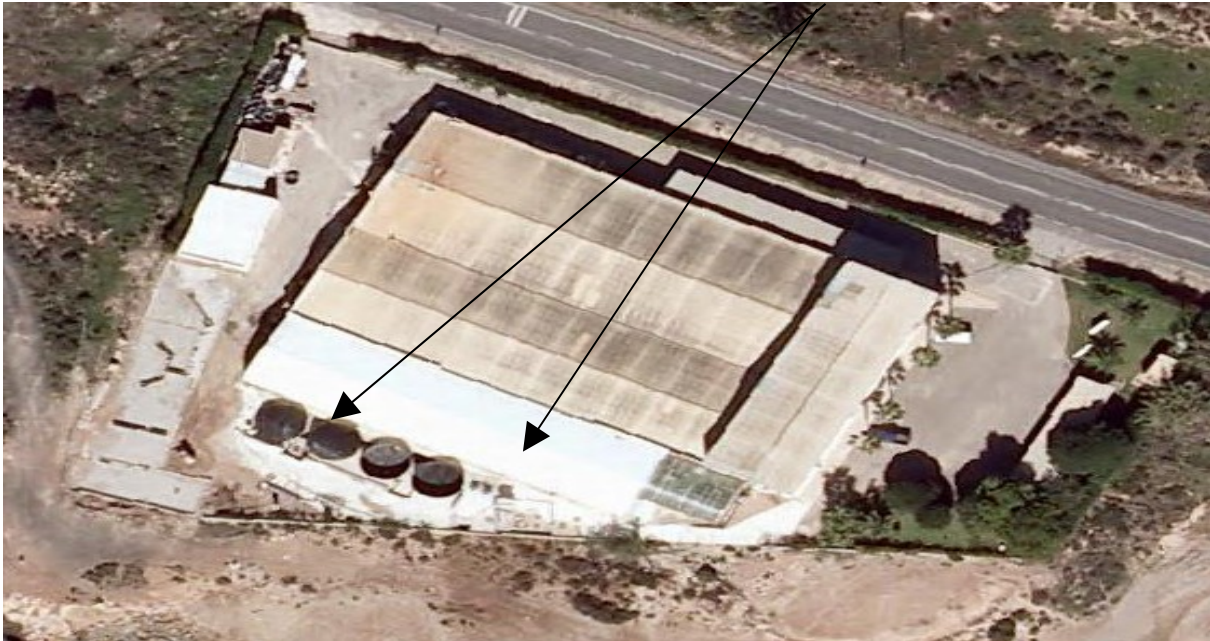
Fig. 1.1 Vista aérea de cubierta donde se ubica la instalación
