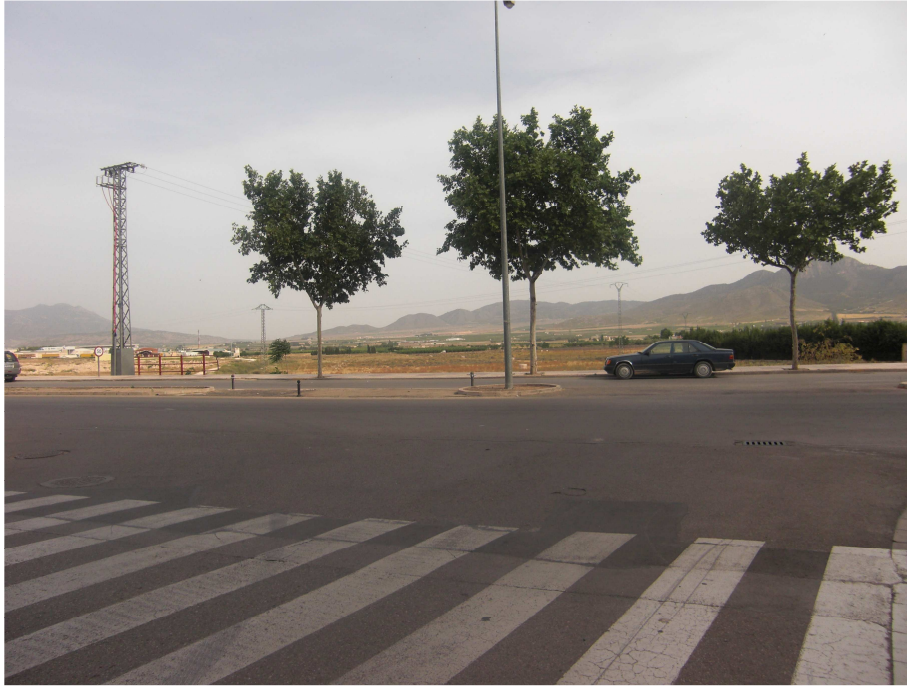
Foto 19. Unión de conducciones donde se sitúa el pozo LIBERTAD7. Al fondo la zona de expansión y donde comienza el colector general.
