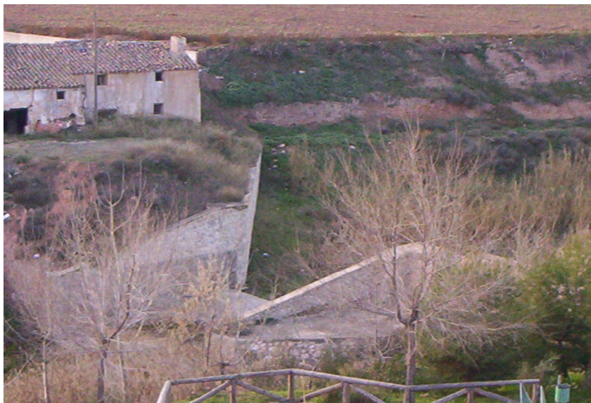
Foto 8. Zona próxima al punto de vertido Judío donde se encuentra la infraestructura de mitigación de avenidas.
