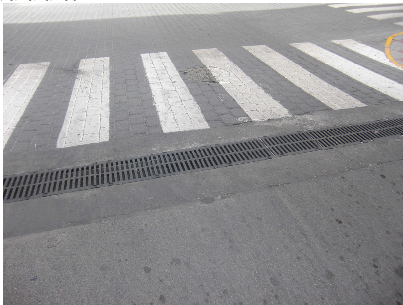
Foto 1. Detalle de imbornal tipo en línea que serían colocados en la futura red hidráulica.
