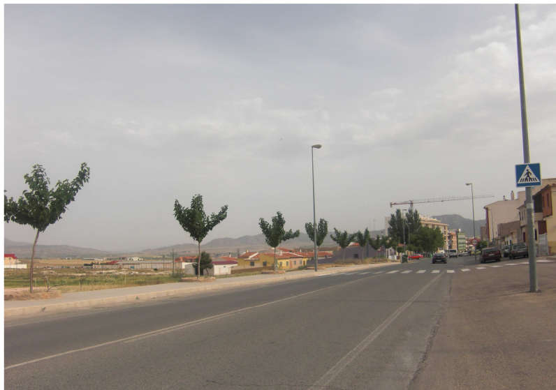
Foto 10. Vista general de la Avenida de Yecla donde desaguan todas las conducciones de la zona 4º Distrito.
