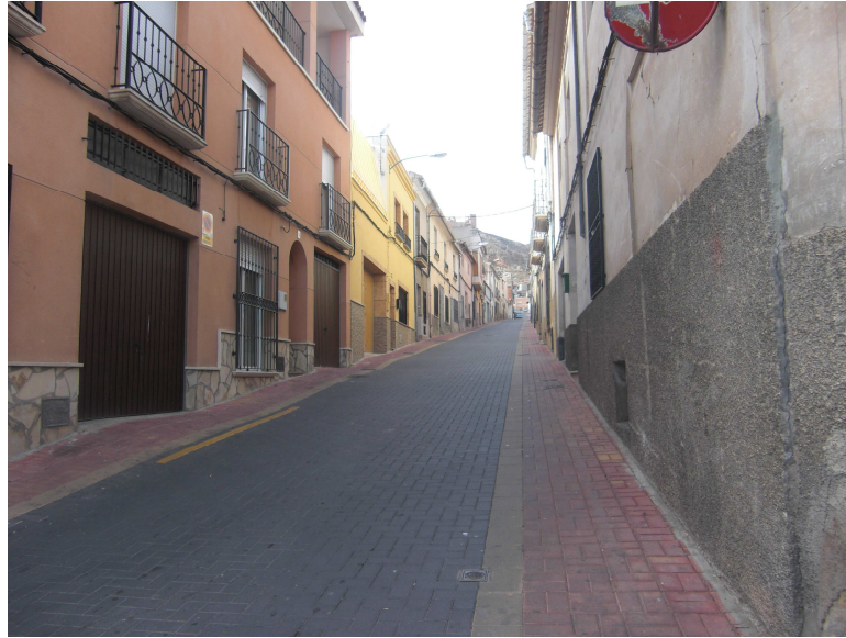
Foto 12. Calle Marchante donde se puede observar aguas arriba por donde discurre el trazado NC-6.
