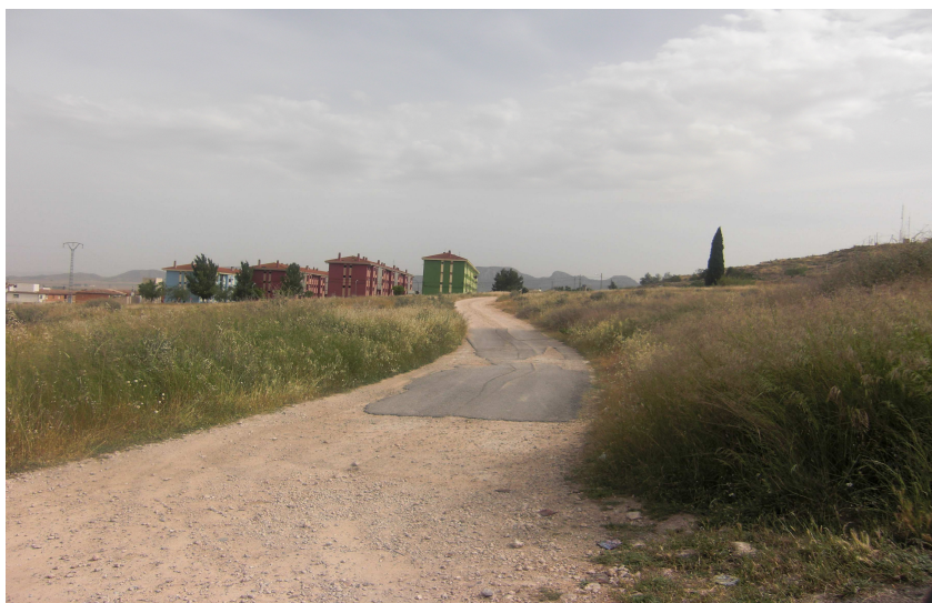
Foto 5. Vista del trazado aguas arriba por donde discurrirá la conducción.
