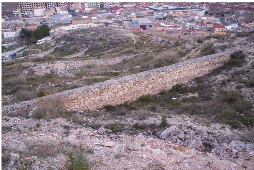
Foto 4. Dique de contención existente que se aprovecharía para la captación inicial del trazado Hermanillos Este.
